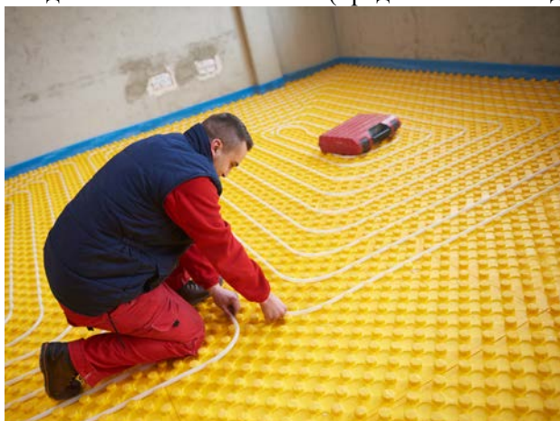
Фиг. 48: Монтаж на подово лъчисто отопление
