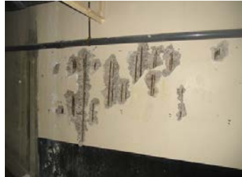
Фиг. 4: Образуване на мъхъл Фиг. 5: Корозия на армировка Фиг. 6: Набъбнал дървен под
