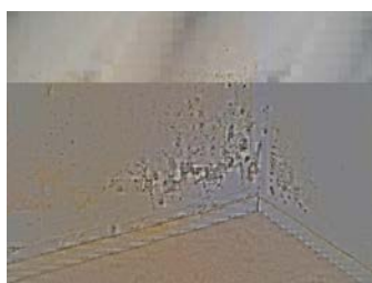
Фиг. 4: Образуване на мъхъл Фиг. 5: Корозия на армировка Фиг. 6: Набъбнал дървен под
