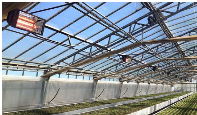
Фиг. 52: Лъчисто отопление в оранжерия
