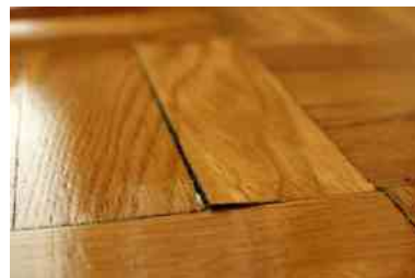
Фиг. 4: Образуване на мъхъл Фиг. 5: Корозия на армировка Фиг. 6: Набъбнал дървен под
