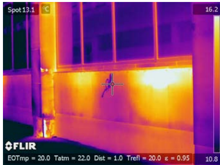
Фиг.70: Термомост в дограма Фиг.71: Дефекти в топлоизолация
