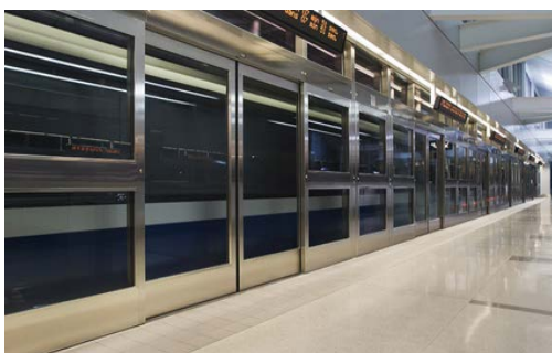
Фиг. 7. Плъзгащи се врати на станция
