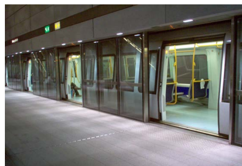
Фиг. 7. Плъзгащи се врати на станция
